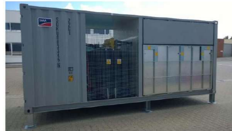
Exemples de poste de transformation en container ou sans enveloppe
