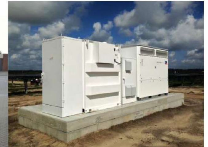
Exemples de poste de transformation en container ou sans enveloppe
