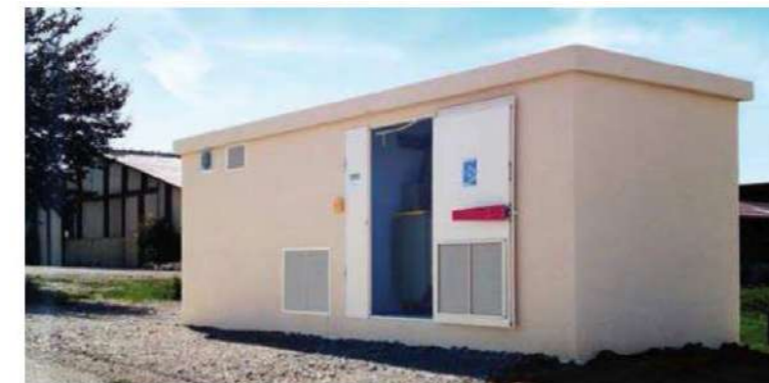
Exemples de poste de transformation préfabriqué
