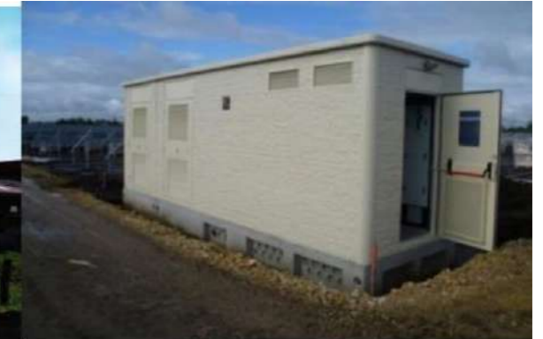
Exemples de poste de transformation préfabriqué
